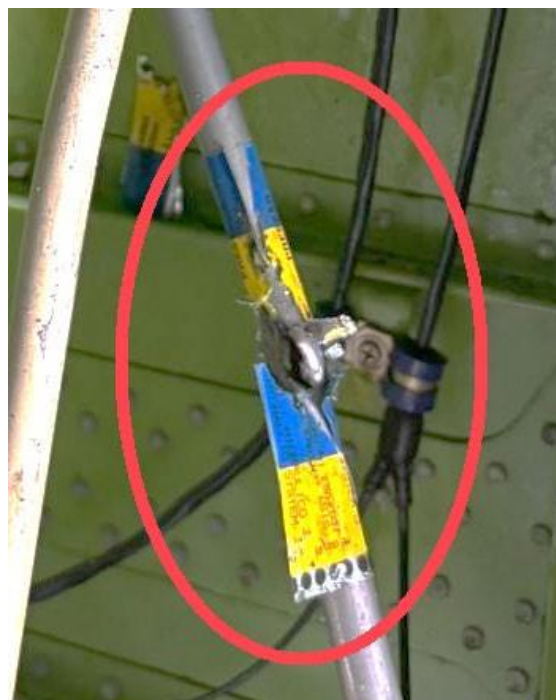
Рис. 16. Гидравлическая система 3 – детальный вид поврежденной трубки
